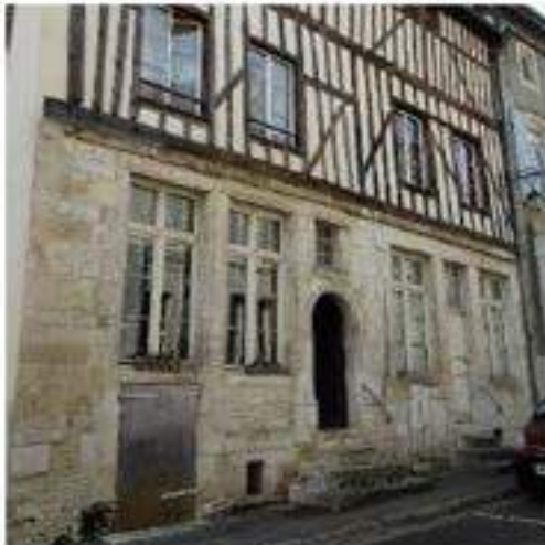
Immeuble 8-10, rue Nicolas Bourbon : un rez-de-chaussée en pierre de taille avec des encadrements de bois moulurés.
