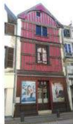
Maison 79, rue Nationale : façade et toiture sur rue (Cl. MH : 23 octobre 1972)
