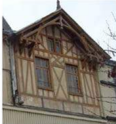
Immeuble d'angle 93, rue Nationale, rue Nicolas Bourbon : Façade d'angle en pan de bois enduit et lambrequins puts façade en pan de bois apparent avec ferme débordante portée par des atselliers.
