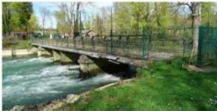
7 - Passerelle au niveau de l'avenue du Parc
