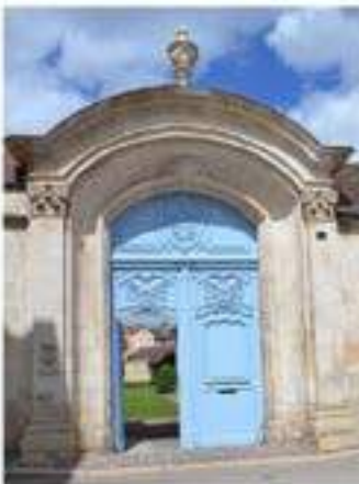
Portail avec ses vantaux, 4 rue Saint-Pierre (Cl. MH : 28 décembre 1979)
