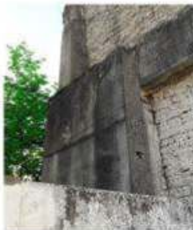
Vestige du mur d'enceinte 24, rue Danton
