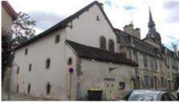
Maison du "Petit Clairvaux" sise à l'angle des rues du Général-Vouillemont et Le Tellier et dépendant de l'immeuble situé 24, rue Beugnot : façade sur rue du Général-Vouillemont avec les deux fenêtres romanes et toiture correspondante ; cave voûtée (IMH : 29 mars 1970)
