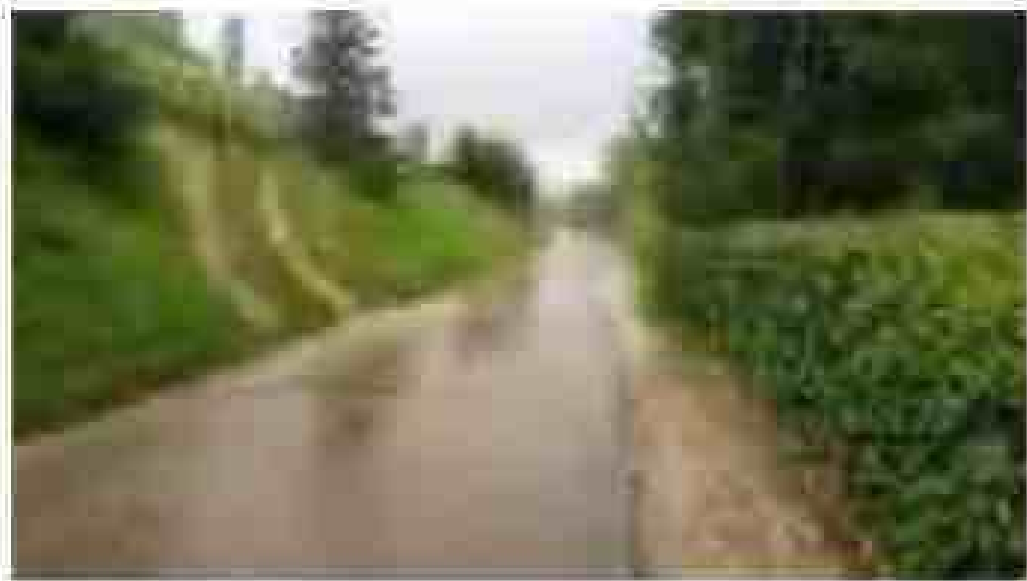
Figure 13 : Ruissellement sur la Rue Gaston Bachelard
