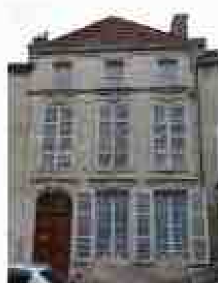
Façade probablement construite au XVIIIe siècle – 15, rue d'Aube
