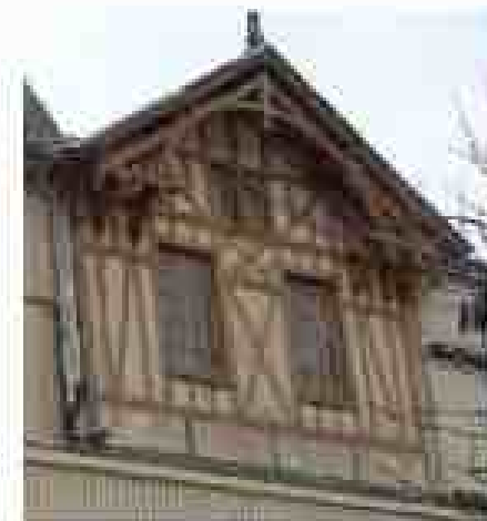
Immeuble d'angle 91, rue Nationale, rue Nicolas Bourbon : Façade d'angle en pan de bois enduit et lambréquins puis façade en pan de bois apparent avec ferme débordante portée par des aiselières.
