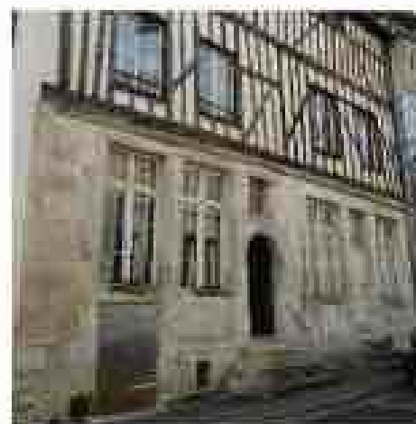
Immeuble 8-10, rue Nicolas Bourbon : un rez-de-chaussée en pierre de taille avec des encadrements de baie moulurés.
