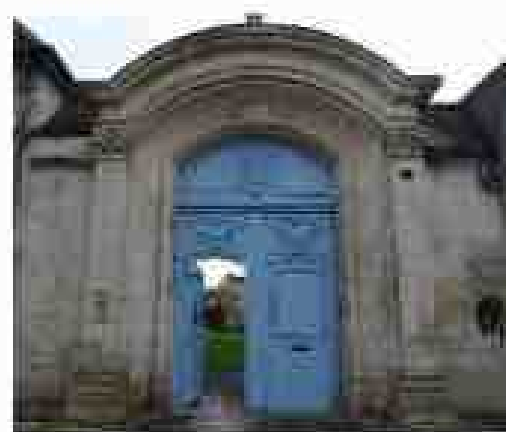
Portail 4, rue St Pierre
