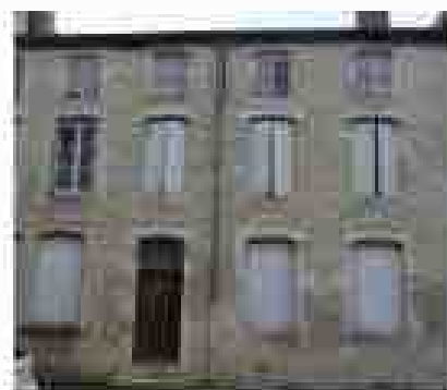
Façades 13, rue d'Aube – Encadrement de baie en pierre de taille avec niveau décalé – Mur en moellons de pierre calcaire d'assises régulières
